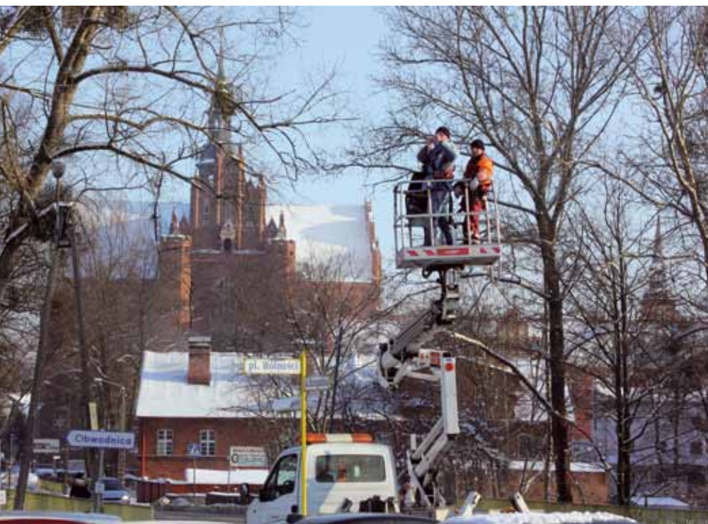
Pierwszym krokiem do przygotowania inteligentnego parkingu jest wykonanie prac pomiarowych.
