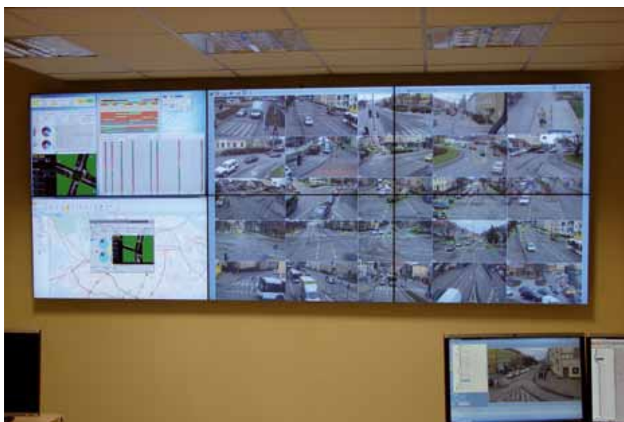
W sali sterowania znajdują się ekrany, na których w czasie rzeczywistym można oglądać olsztyńskie skrzyżowania, dokonywać zmian w sygnalizacji i ustalać objazdy w razie prac drogowych i kolizji.
