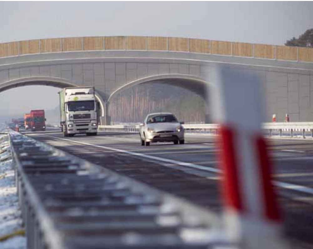
Fot. Autostrada Wielkopolska
