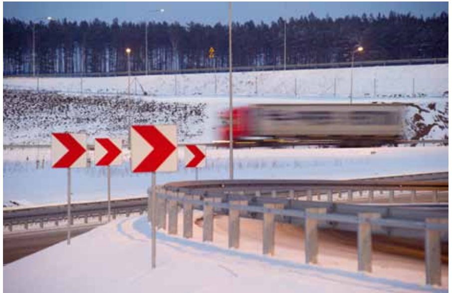
Fot. Autostrada Wielkopolska
