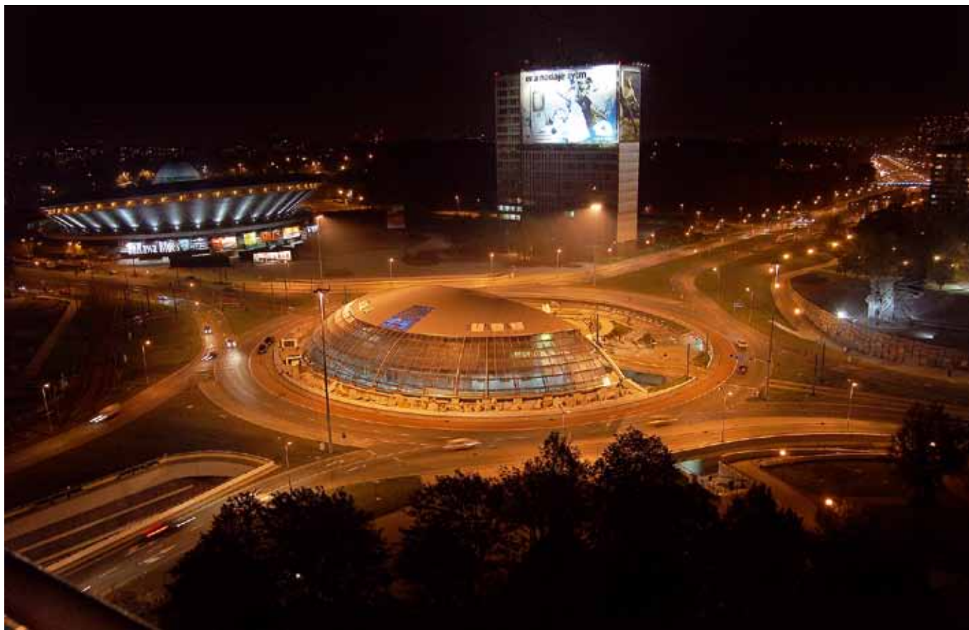
Rondo gen. Jerzego Ziętka w Katowicach
