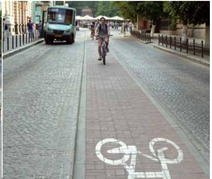
5. Niekonwencjonalny sposób prowadzenia jednokierunkowej drogi dla rowerów
